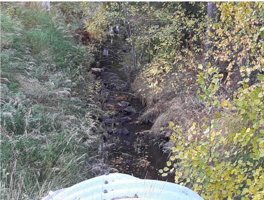
Kuva 14. Piipalantien kohdalla olevaa virta-aluetta
